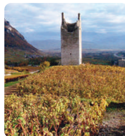
FAÇADES NORD ET OUEST DE LA TOUR © L. Freschi
