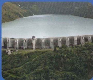
Barrage de la Girotte.
